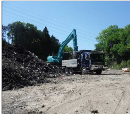
①-1 D・E工区掘削
