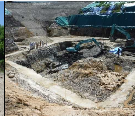
①-3 B工区掘削
