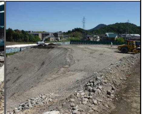
②-2 A工区仮置
