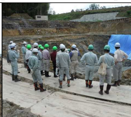
①-3 B工区掘削 B工区における地山の範囲に関する見学会を開催しました。
