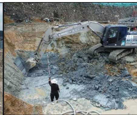
⑤ 浸透水取水設備工 B工区で揚水ピット部の掘削を行っています。
