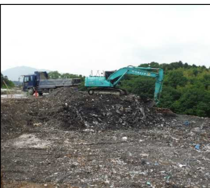
①-1 D・E工区掘削 D工区を掘削しています。
