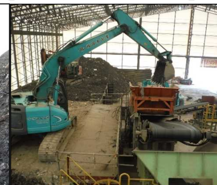
③ 選別処理工 自走式スクリーンへ廃棄物土を投入しています。
