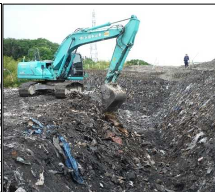
①-1 D・E工区 D工区を掘削しています。
