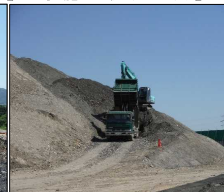
② 選別土仮置・盛土工
