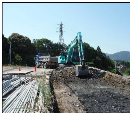
①-1 D・E工区、H区画掘削
