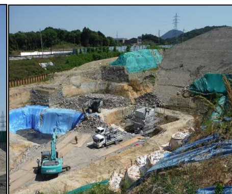
⑥ 浸透水取水設備工
