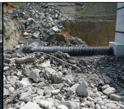
④ 底面排水工 排水管を碎石、再生材で埋戻しています。
