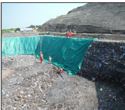
①-1 D・E工区、H区画掘削 H区画法面をキャッピングしています。
