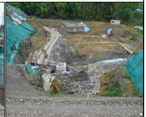
④ 浸透水貯留層工
