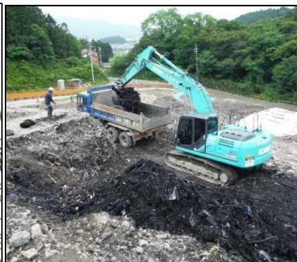
①-1 D・E工区、H区画掘削
