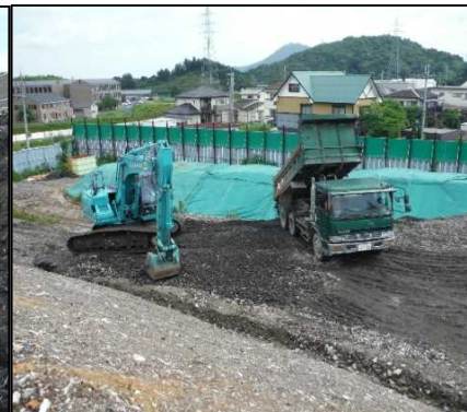
②-2 A工区仮置 選別土をA工区へ仮置きしています。
