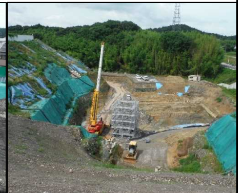
⑤ 浸透水取水設備工 揚水ピットを据え付けています。
