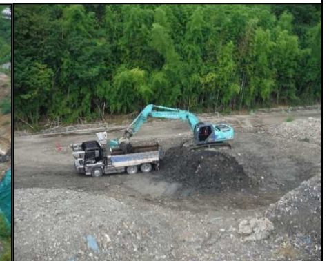
その他 B工区から掘削し、場内に仮置きしていた家庭系ごみを場外搬出しています。
