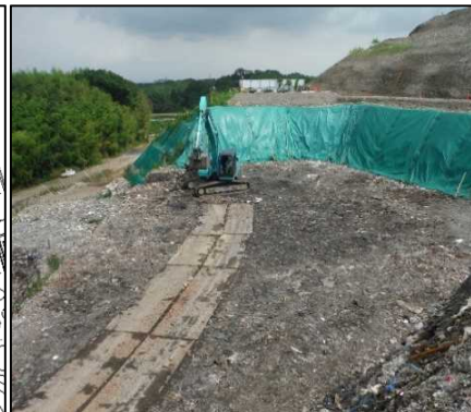
①-1 D・E工区、H区画掘削 H区画の掘削をしています。
