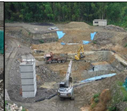
①-3 B工区掘削 浸透水貯留層を設置するため、連続壁内の沖積層の土砂を標高122mまで掘削しています。
