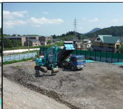
②-2 A工区仮置
