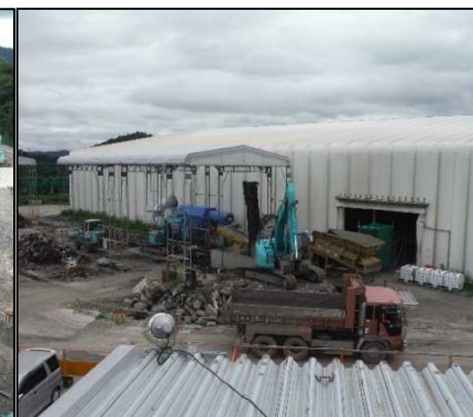
⑤ 選別処理工 粗選別で選別された120mmオーバーの再生材を積み込んでいます。
