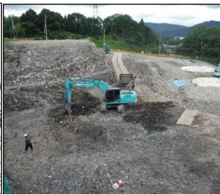
①-1 D・E工区、H区画掘削 H区画の廃棄物土を掘削しています。
