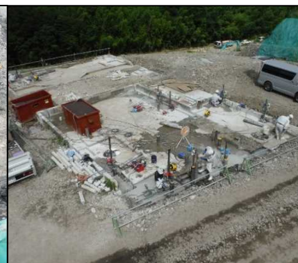
④ 仮設備工(既設杭撤去) コアボーリングで基礎杭と床、梁との縁切りを行っています。
