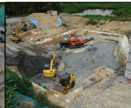
⑥ 底面・側面遮水工 B工区粘土欠損部を改良土にて遮水工を行っています。
