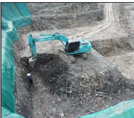
①-1 D・E工区、H区画掘削 H区画の有害物土を掘削しています。
