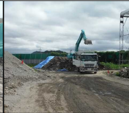
② 有害物掘削工
