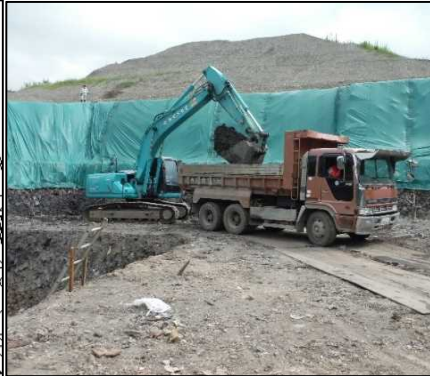
①-1 D・E工区、H区画掘削
