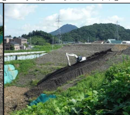
③ 選別土仮置・盛土工 A工区へ選別土を仮置きしています。
