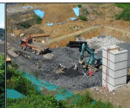
⑥ 底面排水工 止水壁内の排水管を敷設しています。
