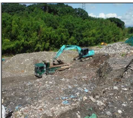
①-1 D・E工区、H区画掘削 H区画の有害物土を掘削しています。
