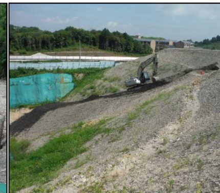
③ 選別土仮置・盛土工 A工区へ選別土を仮置きしています。
