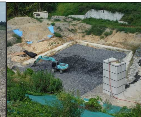
⑦ 浸透水貯留層工 止水壁内に割栗石を敷き均しています。
