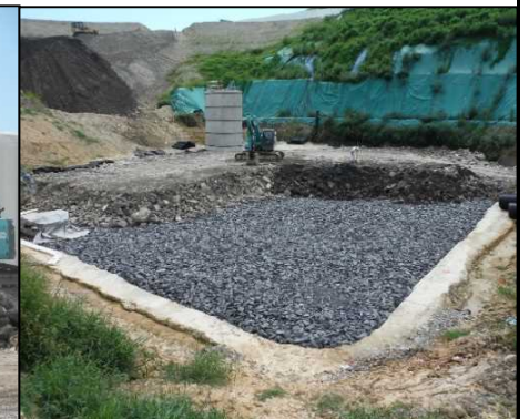
⑦ 浸透水貯留層工 貯留層工の資材を敷均しています。
