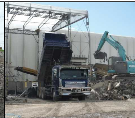
⑤ 選別処理工 粗選別ヤードへ廃棄物土を運搬・搬入しています。
