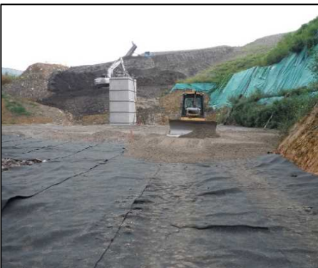
⑦ 浸透水貯留層工 再生材の上に不織布を敷き砕石を敷均しています。
