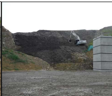
③ 選別土仮置・盛土工 選別土をA工区へ仮置き、B工区へ埋戻しています。
