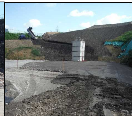
③ 選別土仮置・盛土工 B工区を埋め戻しています。
