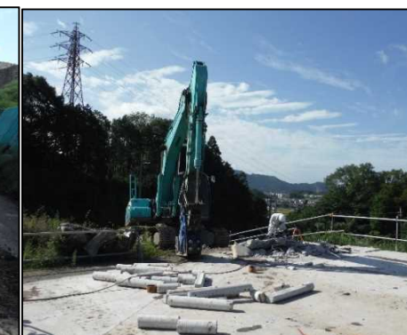
④ 構造物撤去工 ブレーカーで土間コンクリートを取り壊しています。
