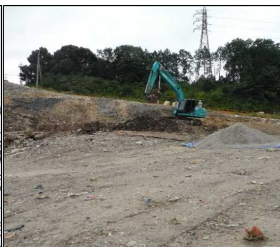
①-1 C・D・E工区掘削 E工区廃棄物土を掘削しています。
