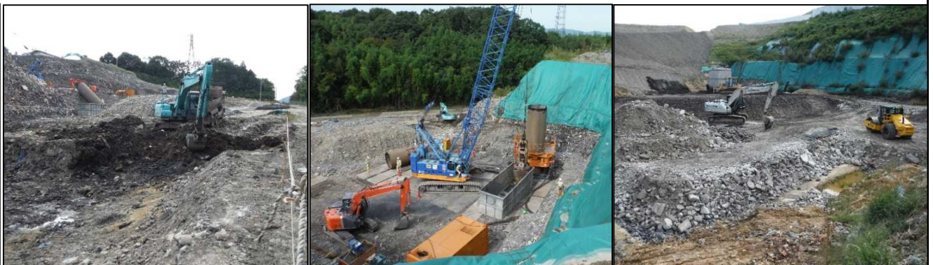
①-1 C・D・E工区掘削
