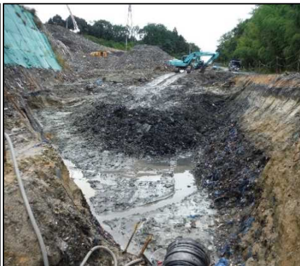
①-1 C・D・E工区掘削
