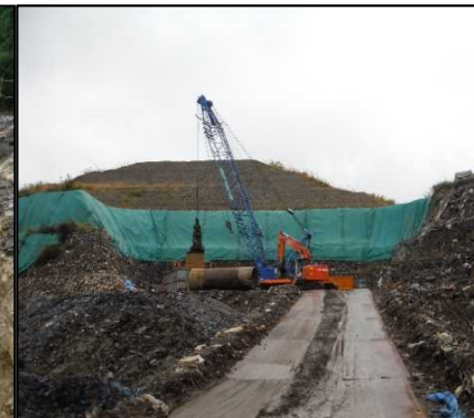
② 有害物掘削工
