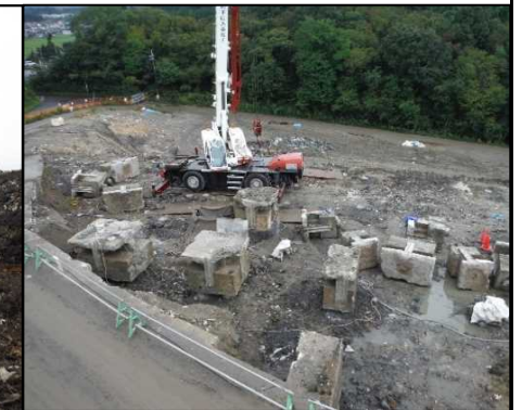
④ 既設杭撤去
