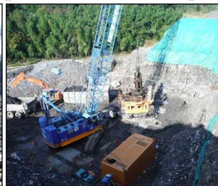
② 有害物掘削工 H-2区画有害物を掘削しています。
