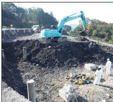
①-1 C・D・E工区掘削 E工区を掘削しています。手前にある袋が磨石綿の疑いのある袋です。
