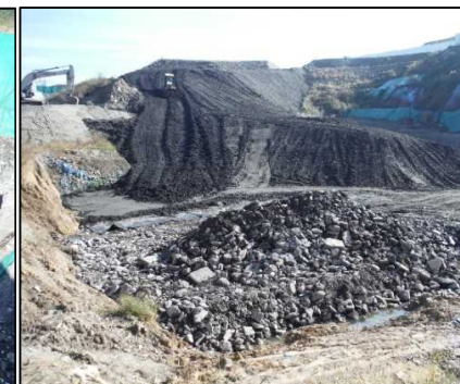
③ 選別土仮置・埋戻し工 B工区を選別土で埋め戻しています。
