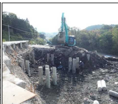
①-1 C・D・E工区掘削 E工区を掘削しています。
