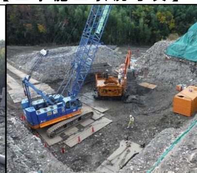
② 有害物掘削工 H-2区画有害物掘削11/9で完了しました。機材を搬出するために解体・清掃を行っています。
