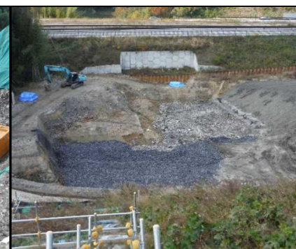
⑦ 浸透水貯留層工 浸透水貯留層に割栗石を敷均しています。
