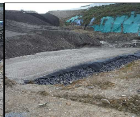
⑦ 浸透水貯留層工 浸透水貯留層の砕石でのフィルター材敷設が終了したところです。
