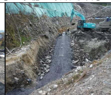
⑥ 底面排水工 底面排水管を設置しています。
