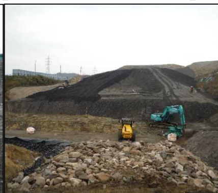
② 選別土仮置・盛土工
