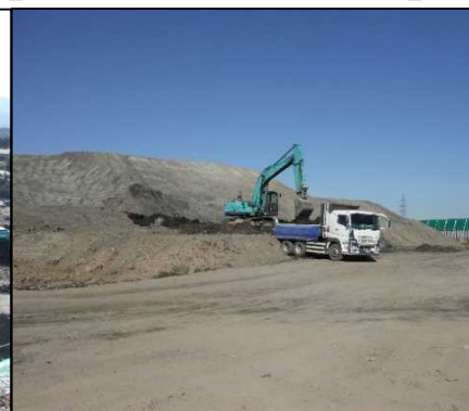
② 選別土仮置・盛土工 仮置選別土をB工区へ運搬しています。
