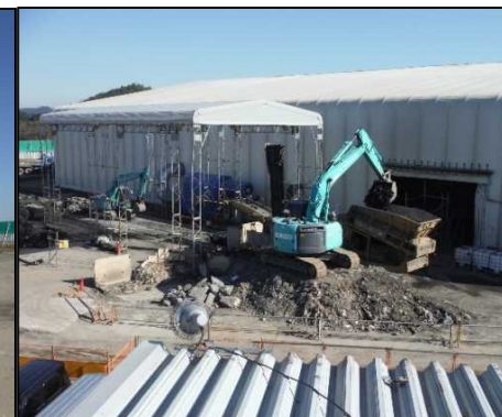
④ 選別処理工 廃棄物土を自走式スクリーンで一次選別(粗選別)しています。
