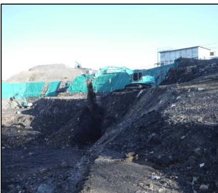
①-1 C・D・E工区掘削 E工区を掘削しています。
