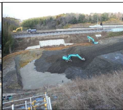
② 選別土仮置・盛土工 B工区を埋め戻しています。
