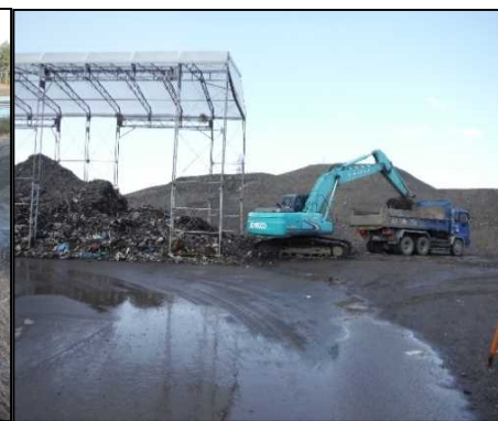
④ 選別処理工 乾燥 Tent から粗選別ヤードへ廃棄物土を運搬しています。
