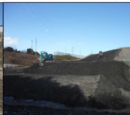
③ 選別土仮置・盛土工
