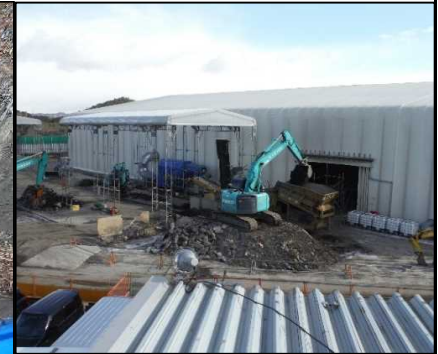
⑤ 選別処理工 自走式スクリーンで廃棄物土を粗選別し ています。
