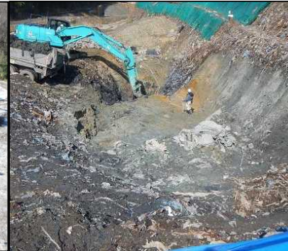
①-1 C・D・E工区掘削 CD工区を掘削しています。 底面排水管設置箇所付近(■)で 地山が確認でき、廃棄物の掘削は掘 止めとしました。
