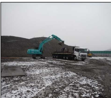
② 有害物掘削工 準備工として工事用道路切替のため敷鉄板を搬入しています。
