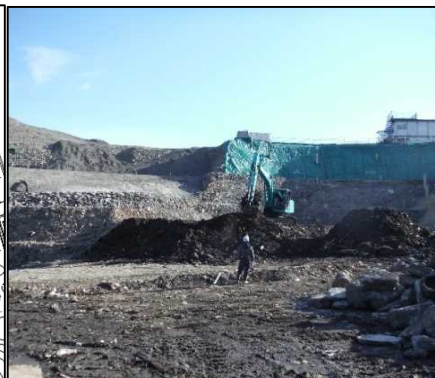
①-1 C・D・E工区掘削
