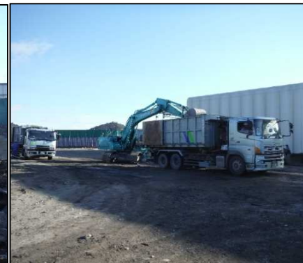
② 有害物掘削工
