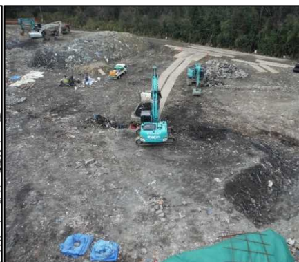
①-1 C・D・E工区掘削
