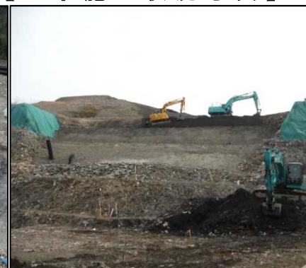
③ 選別土仮置・盛土工
