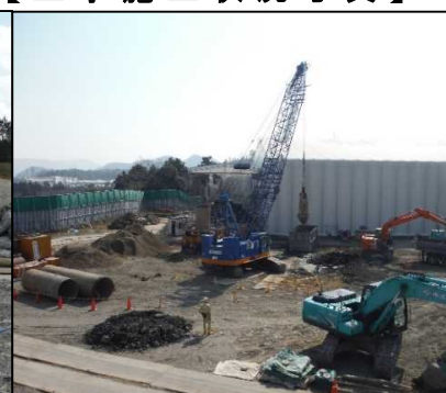
② 有害物掘削工 全巡回でC・D区画矢板部の掘削、置換を行っています。
