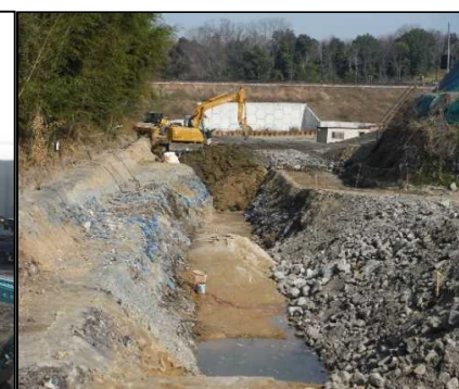
⑥ 鉛直遮水壁工 C工区鉛直遮水壁施工部を粘土で埋戻しています。
