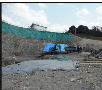
①-1 C・D・E工区掘削 D工区を掘削しています。
