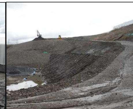
④ 選別土仮置・盛土工
