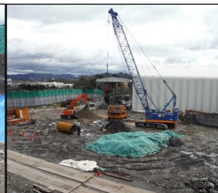
② 有害物掘削工
