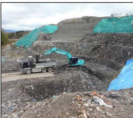
①-1 C・D・E区掘削
