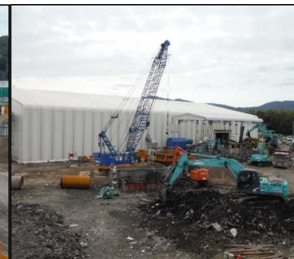
② 有害物土掘削 全巡回でC・D区画矢板部の掘削、置換を行っています。
