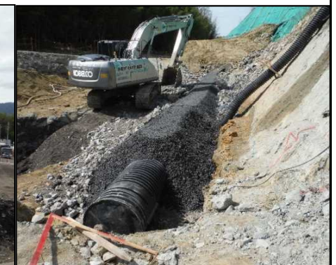
⑦ 底面排水工 底面排水管を設置しています。
