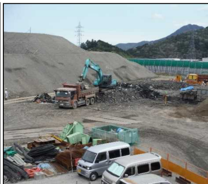
①-2 廃棄物土乾燥 廃棄物土を乾燥し粗選別へと運搬しています。
