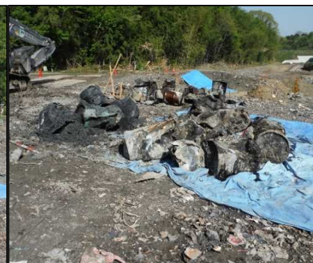
② 有害物土掘削
