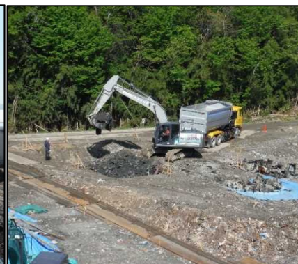
② 有害物土掘削
