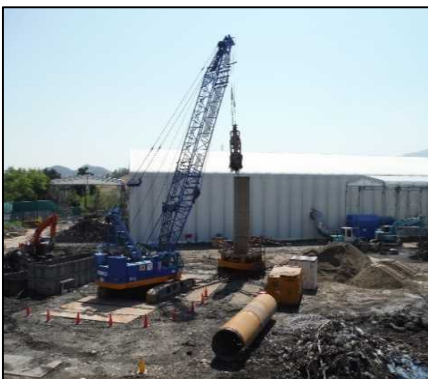
② 有害物土掘削
