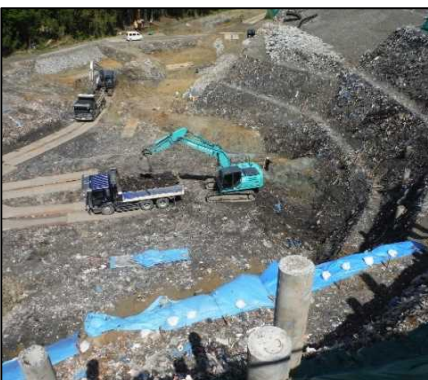
①-1 廃棄物土掘削工 D工区を掘削しています。
