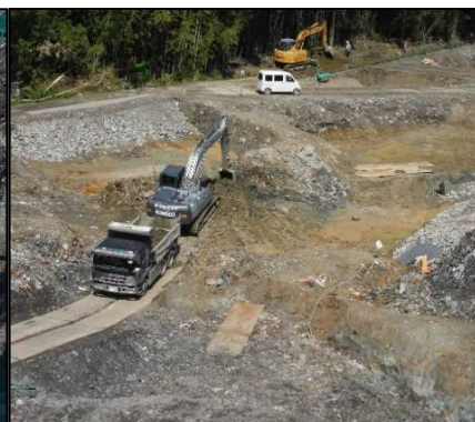
①-1 廃棄物土掘削工 C工区を掘削しています。
