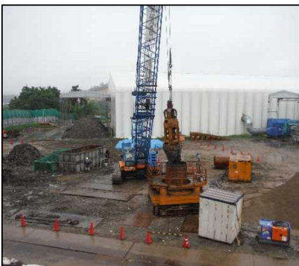
② 有害物土掘削
