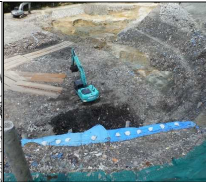
① 廃棄物土掘削工 E工区の廃棄物土を掘削しています。
