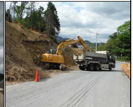
③ 伐開工 工事用進入路の掘削を行っています。
