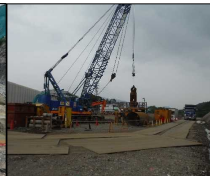
② 有害物土掘削工 全周回でC区画矢板部の掘削、置換を行っています。
