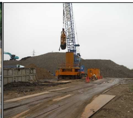
② 有害物土掘削工 全巡回でC区画矢板部の掘削、置換を行っています。
