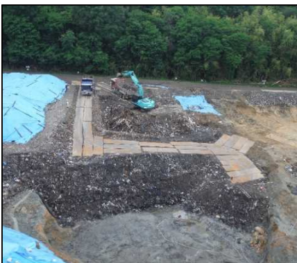
① 廃棄物土掘削工 D工区の廃棄物土を掘削しています。
