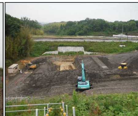
⑦ 地盤改良工 B工区放流設備地盤改良を行うために仮置きした選別土を掘削、移動しています。
