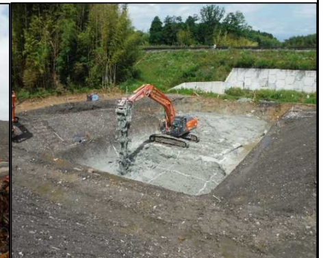
⑦ 地盤改良工 B工区放流設備の下部の地盤改良を行っています。
