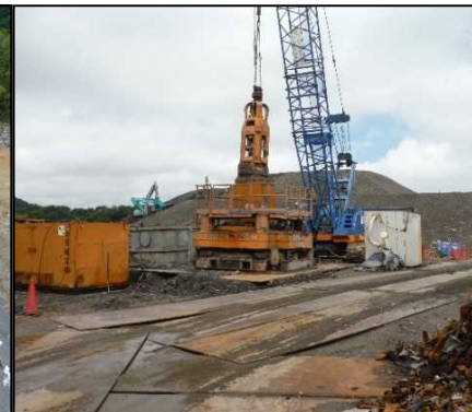
② 有害物土掘削工 全周回でC区画矢板部の掘削、置換を行っています。
