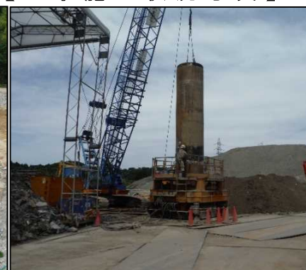
② 有害物土掘削工 全旋回のケーシングを接続しています。
