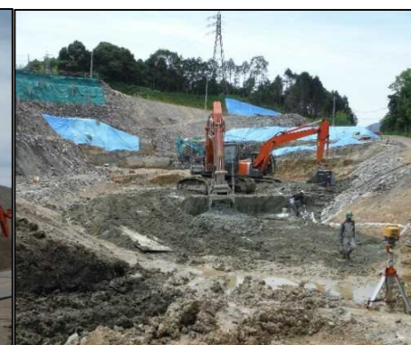
⑦ 地盤改良工 CD工区の地盤改良を行っています。
