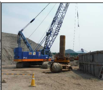
② 有害物掘削工
