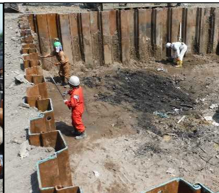
② 有害物掘削工
