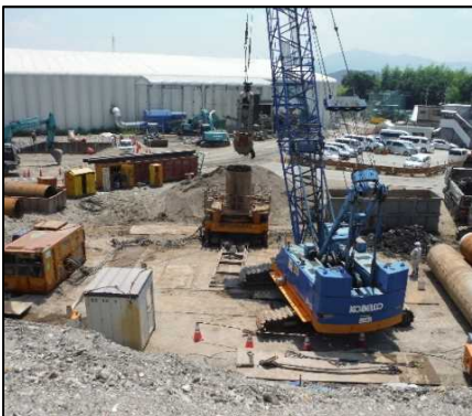
② 有害物掘削工
