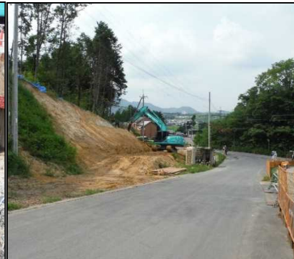
③ 伐開工 入口道路部の法面整形掘削を行っています。
