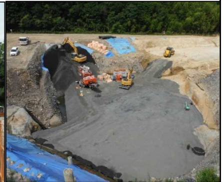
⑦ 底面・側面遮水工 底面遮水工を行っています。
