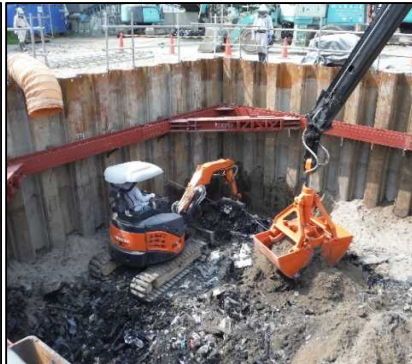
② 有害物掘削工 D区画の二次掘削(廃棄物土)を行っています。
