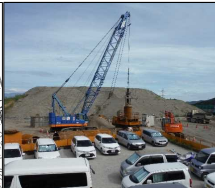
② 有害物掘削工 FG区画の置換杭を掘削しています。
