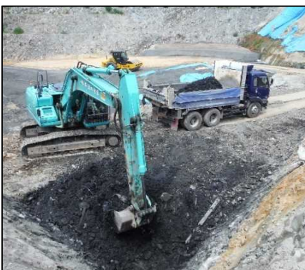
①-1 廃棄物土掘削工 E工区の廃棄物土を掘削しています。
