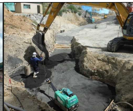
⑥ 底面・側面遮水工 CD工区底面遮水工を行っています。
